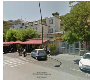
Vista ingresso appartamento sub.10
